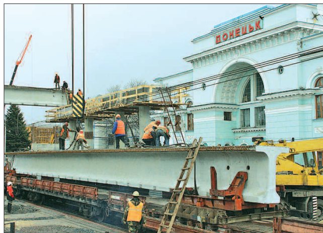
Станція «Донецьк» набуває сучасного вигляду
