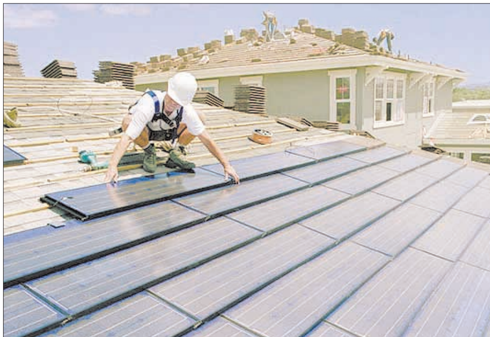
Монтаж сонячних панелей триває лише пару годин
