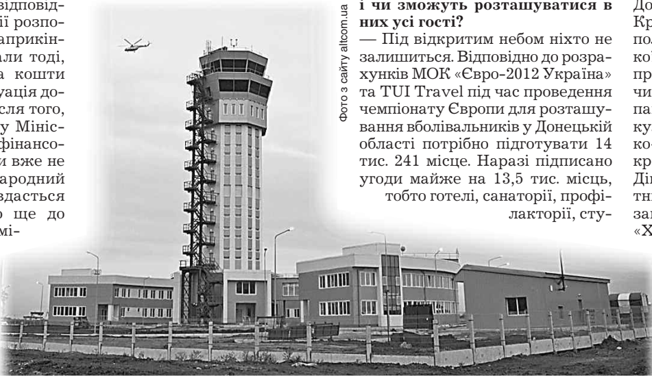
Завершено будівництво нової, найвищої в Україні (понад 51 м), аеродромно-диспетчерської вежі міжнародного аеропорту «Донецьк»
