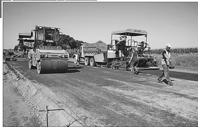
Триває реконструкція М-03
