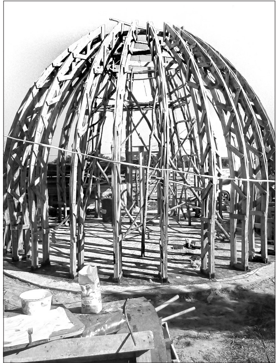
На Сумщині підприємці одними з перших в Україні почали зводити купольні будинки із використанням костробретону
