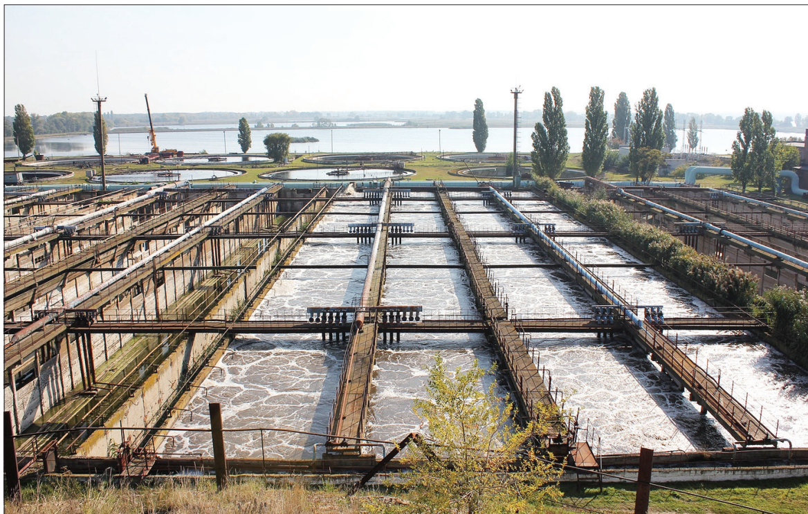
Очисні споруди міста мають відмінно працювати — це розуміють усі
