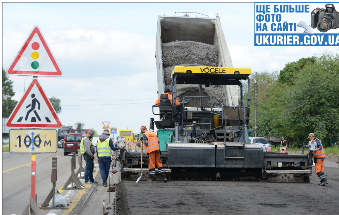
Коли тандемними та комбінованими котками утрамбують перший шар дороги, на неї покладуть сітку Рабіца для зміцнення автошляху з тришарового автобетону
