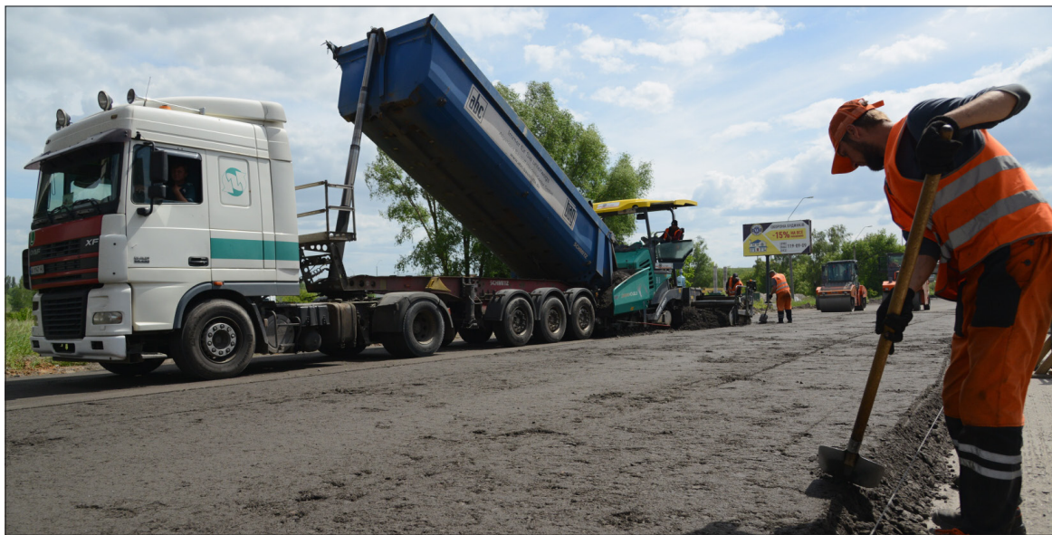
Найвідповідальніший етап будівництва автодороги — закладання першого шару, її «фундаменту»
